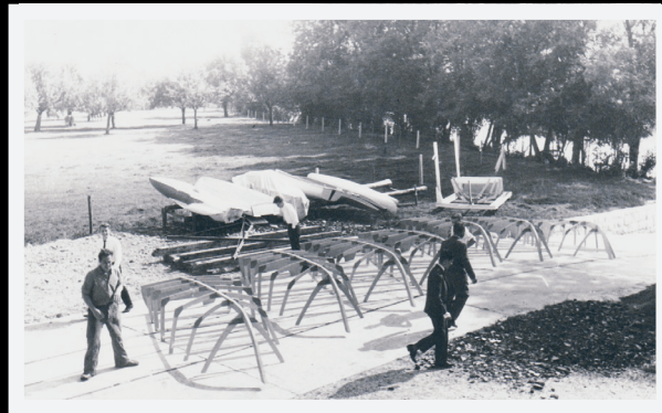
1963 Baubeginn der ersten grossen Serie: Lehmann 460. Auf der 1962 fertiggestellten Werftanlage/Rampe (Standort der Werft bis heute) stehen die ersten sieben Rohlinge/Gerippe der neuen 460er-Serie.
